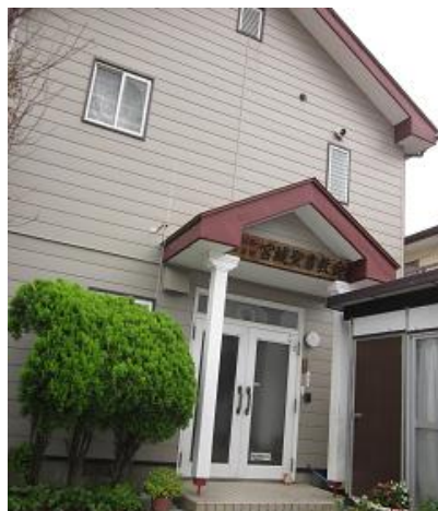
基督聖教団・宮城教会 津波で1階部分まで浸水して大きく破損しましたが、現在は修復を完了しています。(2012.8.3)
