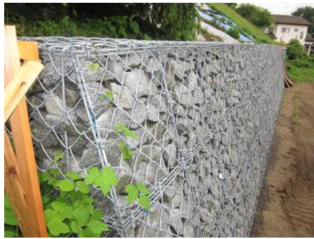
保守バプテスト同盟・郡山聖書バプテスト教会 地震で教会の斜面が崩落する危険がありましたが、新しく石積み方式の擁壁が設置されました。(2012.8.6)
